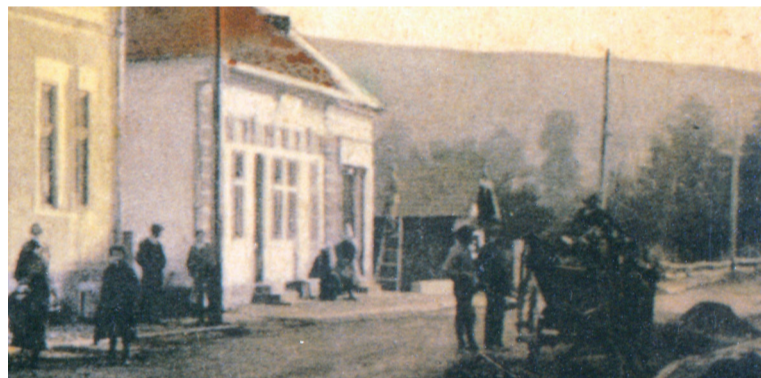
Drevený Barankovský dom v strede, napravo od domu Menkynnu, na dnešnej križovatke Ulice M.R.Štefánika a Beskydskej.
